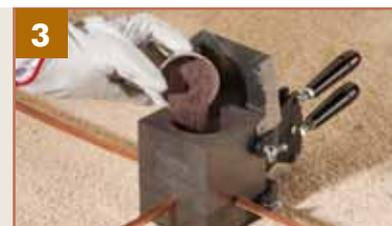
3 Vaciar el contenido del envase de compuesto de soldadura.
